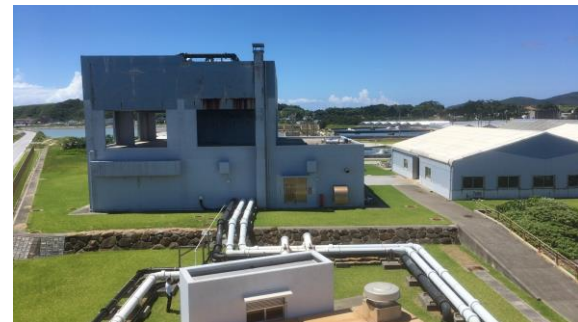
海洋深層水取水ポンプ室
